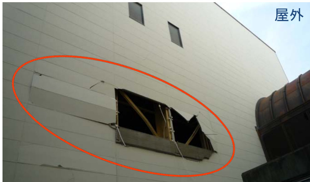
応急補修(雨仕舞い)後
